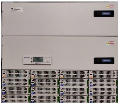
Infinity NE-S Power System (Pulsar Plus)
